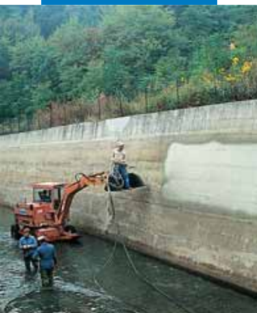
Aplikacja Idrosilex Pronto metodą natrysku w kanale hydroelektrowni
