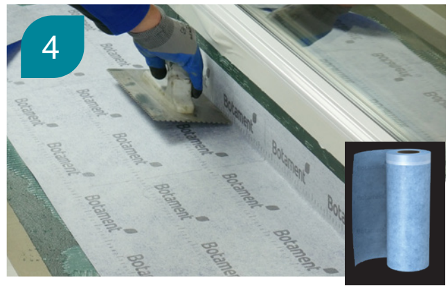
4 Wklejenie taśmy uszczelniającej BOTAMENT® PB Portalband na balkonach z czynnikiem termicznym.
