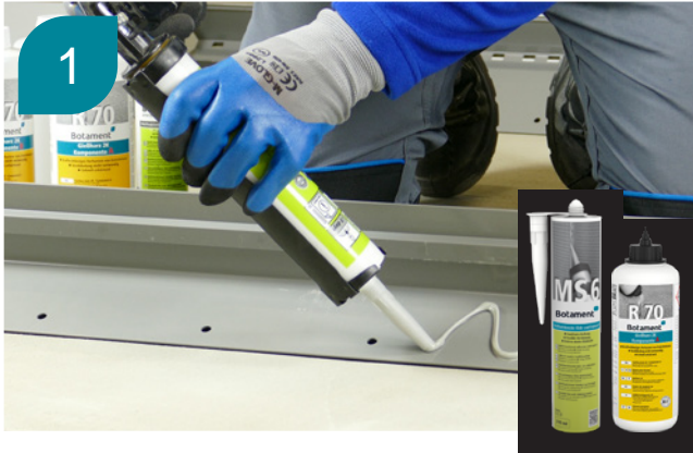
1 Wklejenie obróbki blacharskiej na uszczelniający klej montażowy BOTAMENT® MS 6 lub żywicę BOTAMENT® R 70.
