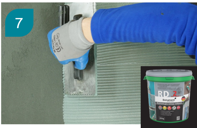
7 Po opanowaniu 2. warstwy hydroizolacji BOTAMENT® RD 2 The Green 1 .
