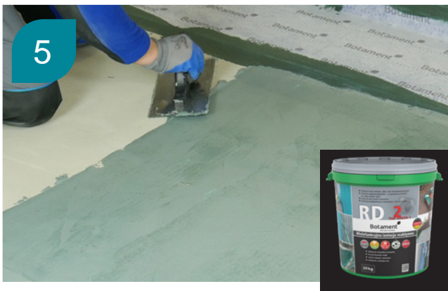
5 Wykonanie szpachlowania na całej powierzchni z użyciem BOTAMENT® RD 2 The Green 1 .
