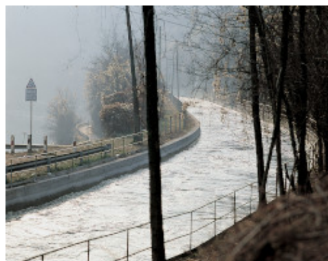
Kanał hydroelektrowni Bertini w okolicach Como, Włochy. Powierzchnie pokryte Planiseal 88
