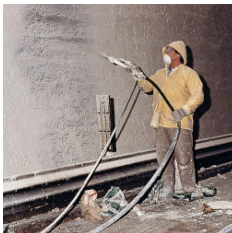
Nanoszenie białego Planiseal 88 w tunelu autostrady
